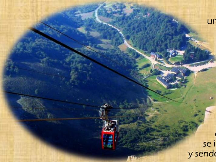
Este lugar posee un teleférico que salva un desnivel de 753 m con una longitud de cable de 1840 m. A la estación superior del teleférico se le llama El Cable. Allí existe un mirador sobre el valle. El trayecto se realiza en poco más de 3 minutos y medio.
